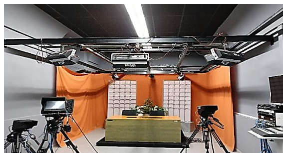
Renovación luminarias en plató de televisión.
